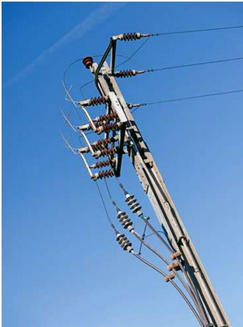
Eine Freileitung ragt in den Himmel – exponiert gegenüber Wind und Wetter. Um die Versorgungssicherheit zu erhöhen und Stromausfälle zu verhindern, bauen die TGB solche Leitungen zurück und setzen auf erdverlegte Kabel.
